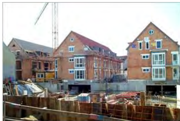
Abb. 6: ...um die Nachfrage nach Wohnungen zu befriedigen, wurden vor allem Baulücken genutzt.
