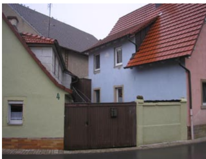
Straßenansicht Haus Nr. 2 (West)
