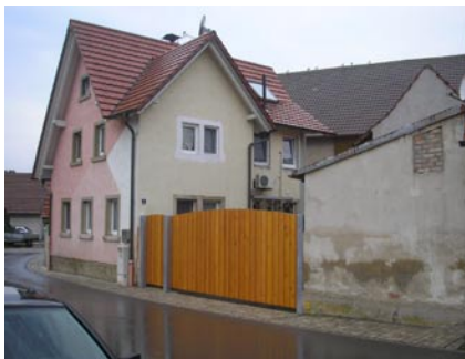
Straßenansicht Haus Nr. 2 (Ost)
