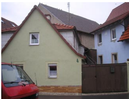
Straßenansicht Haus Nr. 4 (Süd)
